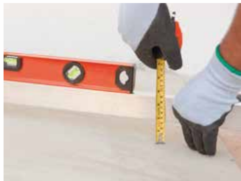
Contrapiso com caimento
