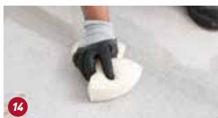
14 Limpeza do rejunte
