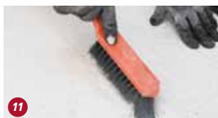
11 Limpeza das juntas
