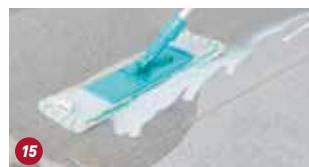
15 Limpeza final e proteção
