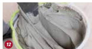
12 Mistura do rejunte
