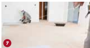
7 Alinhamento das placas
