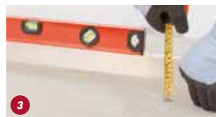
3 Verificações antes do início do assentamento
