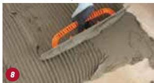
8 Aplicação da argamassa
