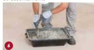
6 Mistura da argamassa colante na argamassadeira
